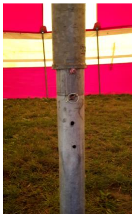
Εικόνα 5: Μεταλλικός κεντρικός πάσσαλος ρυθμιζόμενου μήκους με πύρο από δύο όψεις και στο βάθος τα κατακόρυφα δομικά στοιχεία
