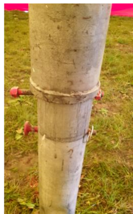
Εικόνα 5: Μεταλλικός κεντρικός πάσσαλος ρυθμιζόμενου μήκους με πύρο από δύο όψεις και στο βάθος τα κατακόρυφα δομικά στοιχεία
